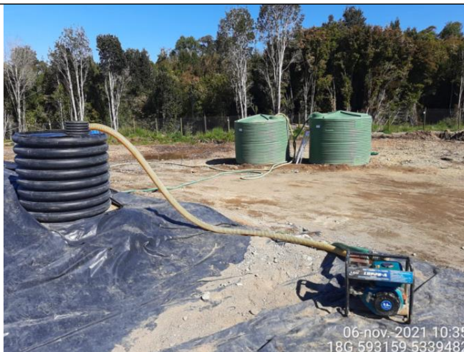
Fotografía N°9: Extracción de Lixiviados desde cámara C10. Tomada: Sábado 06 de Noviembre del 2021.
