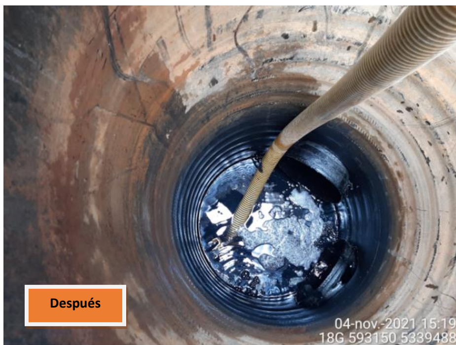
Fotografía N°5: Antes y después de cámara por extracción de Lixiviados. Tomada: Jueves 04 de Noviembre del 2021.
