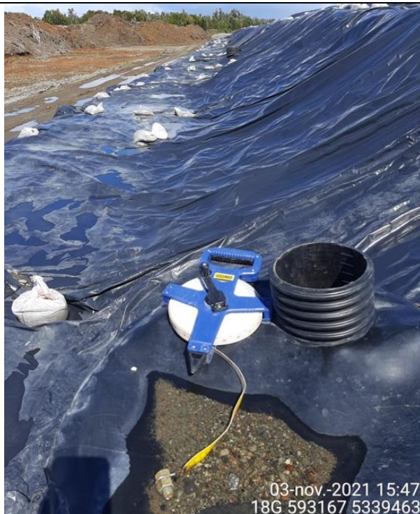
Fotografía N°14: Medición de Niveles de cámaras por Personal Municipal. Tomada: 03 de Noviembre del 2021.
