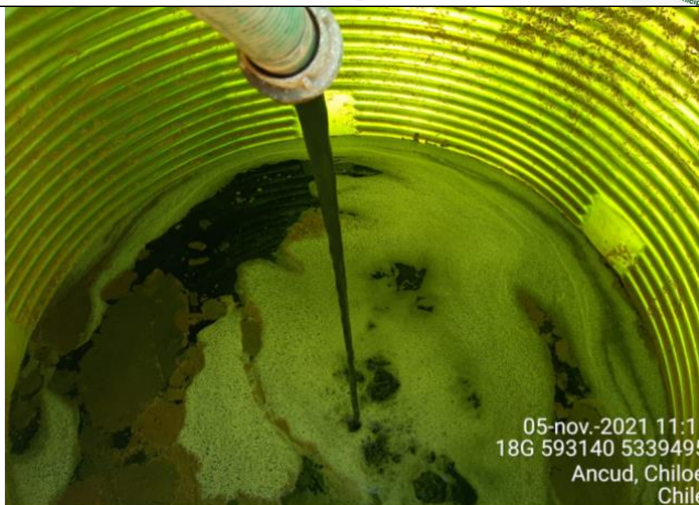
Fotografía N°8: Retiro de Lixiviados a estanque de acumulación. Tomada: Viernes 05 de Noviembre del 2021.
