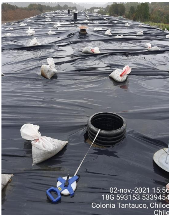
Fotografía N°13: Medición de Niveles de cámaras por Personal Municipal. Tomada: 02 de Noviembre del 2021.
