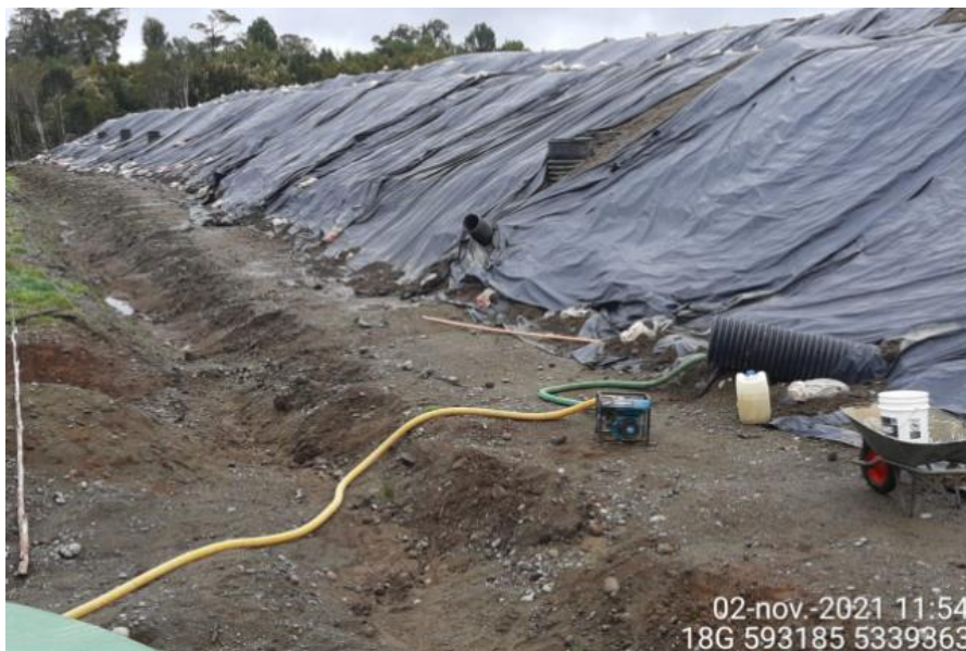
Fotografía N°1: Retiro de Lixiviados desde diagonal D02 por Personal Municipal. Tomada: Martes 02 de Noviembre del 2021.
