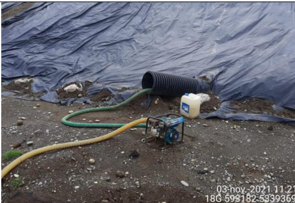
Fotografía N°3: Retiro de Lixiviados desde diagonal D02 por Personal Municipal. Tomada: Miércoles 03 de Noviembre del 2021.
